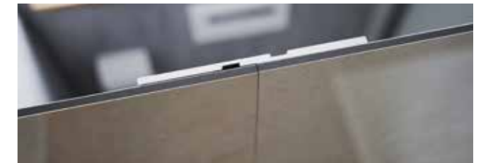
Stoß auf Stoß Montage mit Hilfe einer Plattenstoßschiene
